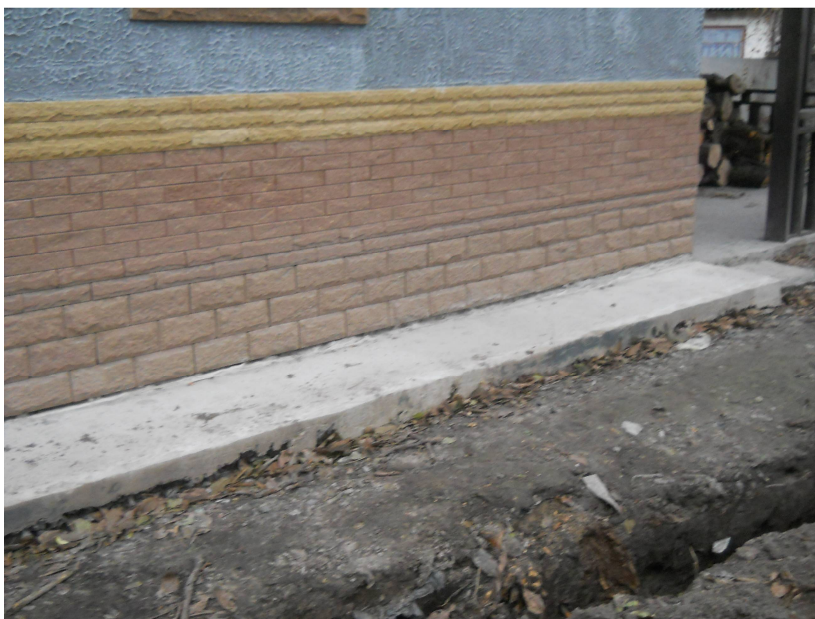
Фото 6. Оздоблення цоколя з фасадної плитки. Вигляд цементно-піщаного вимощення будинку.
