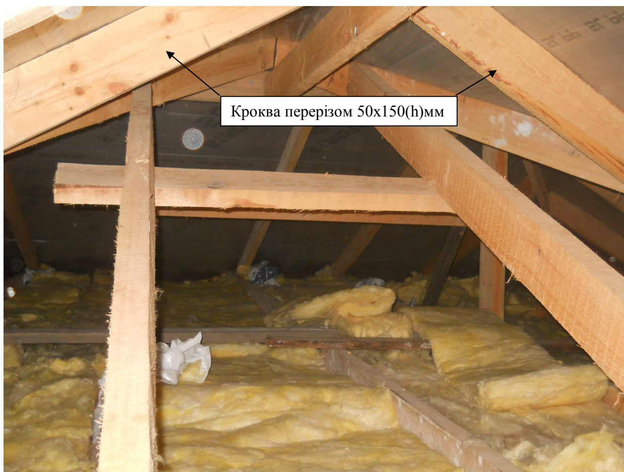
Фото 33. Загальний вигляд кроквяної системи даху будинку.
