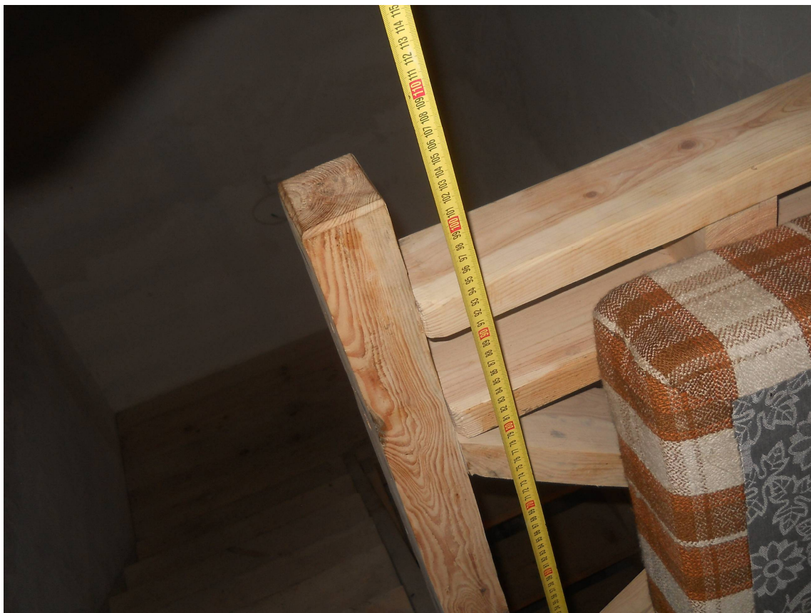
Фото 25. Дерев'яне огородження сходів на відмітці \pm 3,300 .
