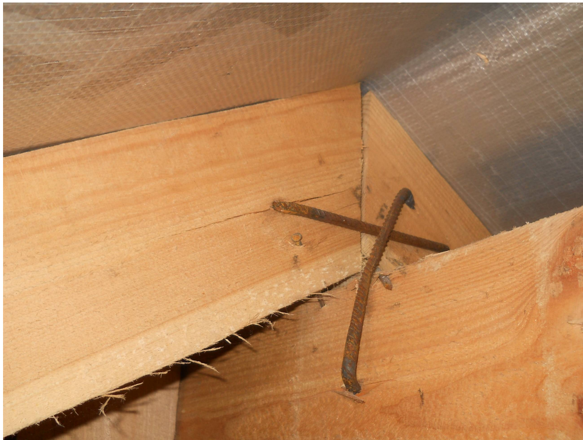
Фото 34. Скобове з'єднання кроквин та конькового бруса.
