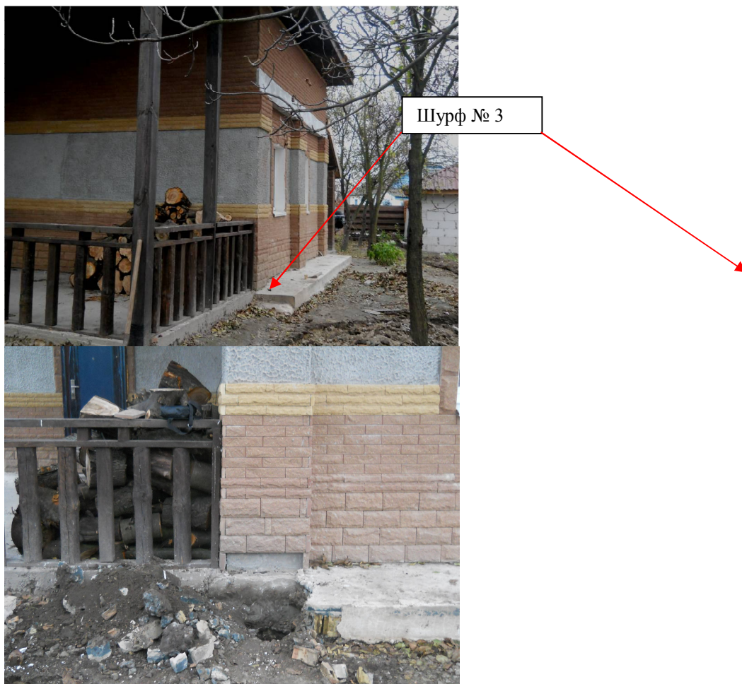
Фото 13. Шурфування ґрунту біля виступу стіни лівого бічного фасаду в осях Г-1.
