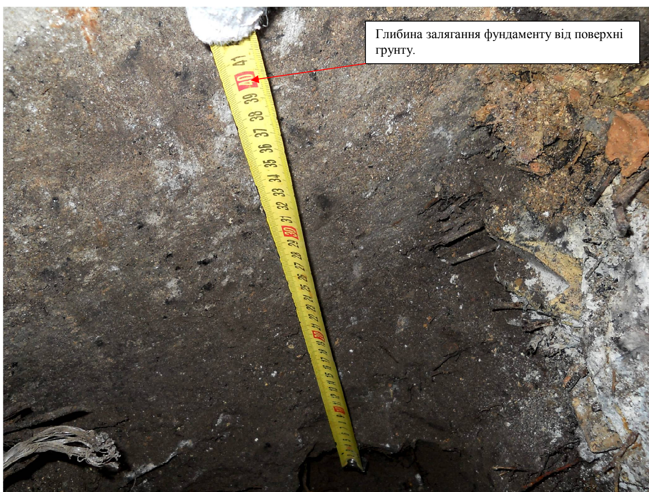
Фото 12. Шурф № 2. Глибина залягання фундаменту під стіну лівого бічного фасаду складає 400 мм.
