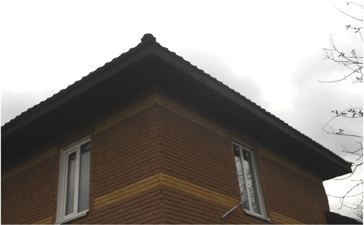
Фото 7. Підшивка звисів даху дошкою з покриттям фарбою. Заповнення віконних прорізів метало пластикowymi вікнами.
