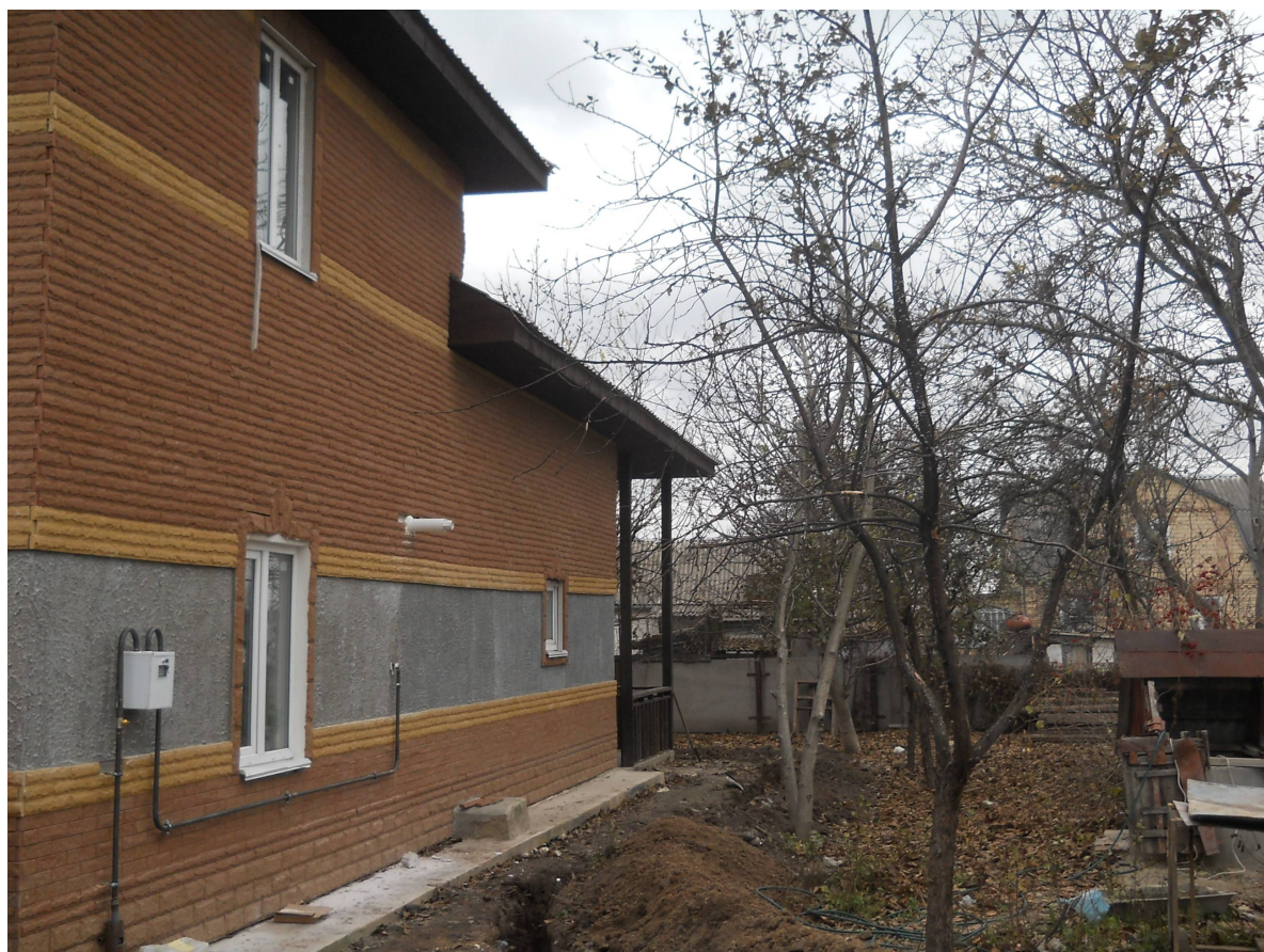
Фото 4. Дворовий фасад по осі Д в осях 5-1. Вигляд дворового простору садиби.
