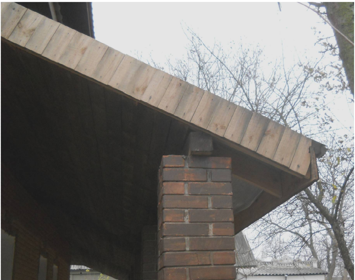
Фото 8. Конструкція даху над терасою № 1. Опорна колона із облицювальної цегли.
