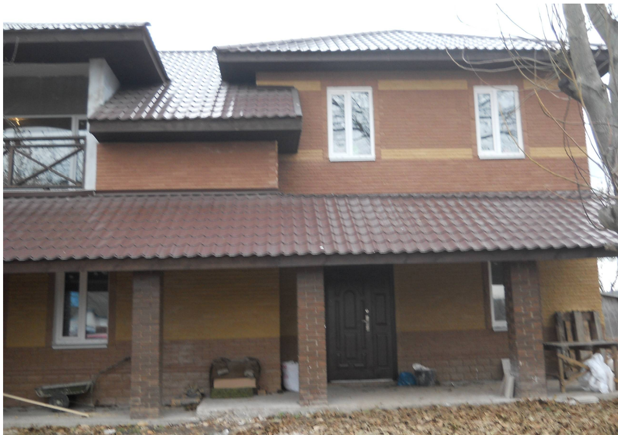
Фото 1. Головний фасад будинку по осі Б, Б1 в осях 3-5. Вигляд тераси № 1.
