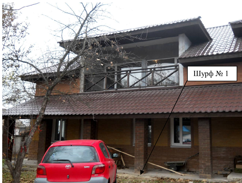
Фото 9. Шурфування ґрунту біля колони тераси № 1 в осях 2б-А.
