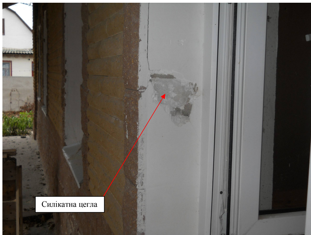
Фото № 17. Обкладення дерев'яних стін старої частини будинку силікатною цеглою. Фрагмент стіни в осях 2б-3/Б.
