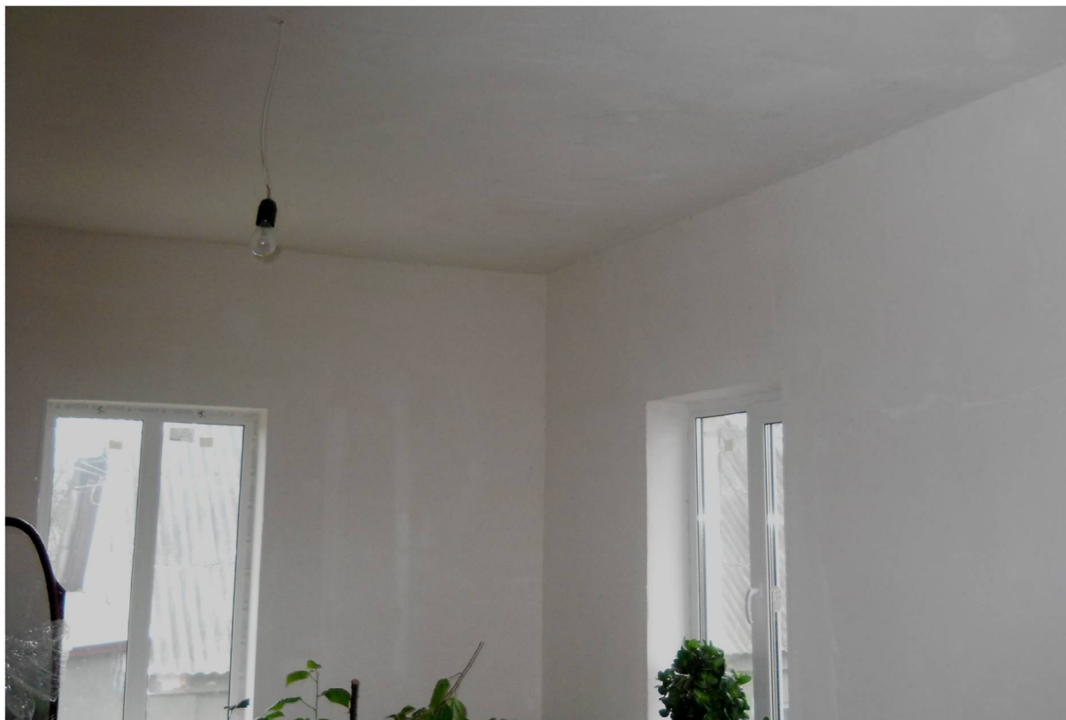
Фото 28. Внутрішнє оздоблення стін мансардного поверху.
