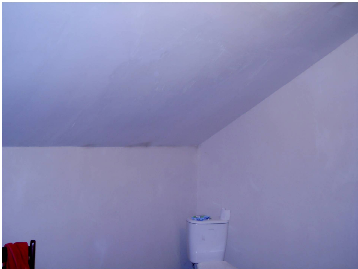
Фото 29. Внутрішнє оздоблення стін санвузла мансардного поверху.
