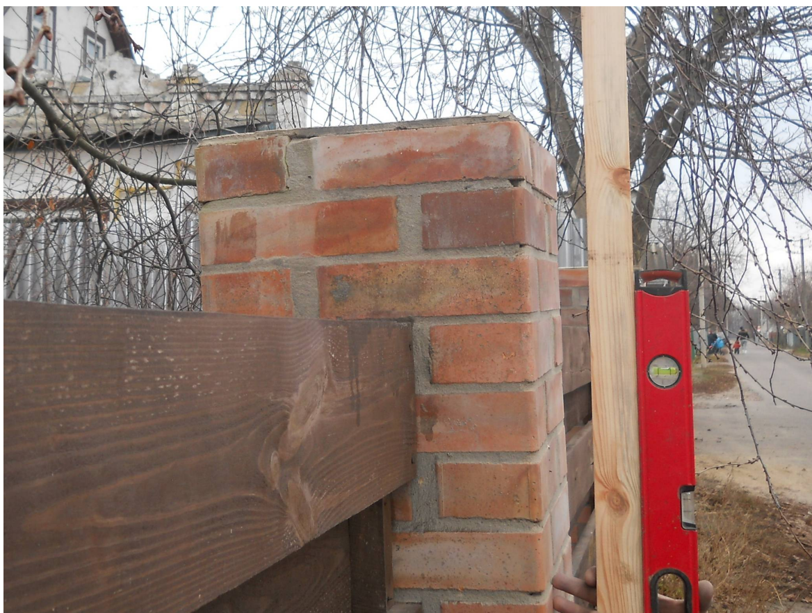
Фото 38, 39. Відхилення від вертикалі цегляних стовпчиків паркану з головного фасаду садиби.
