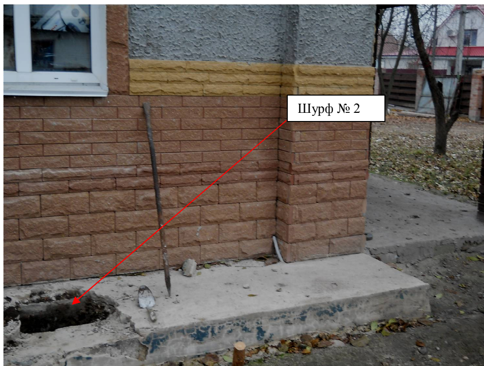
Фото 11. Шурфування ґрунту біля підвіконня з лівого бічного фасаду в осях Б1-В по осі 1.
