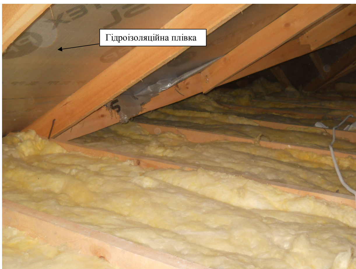
Фото 35. Шар утеплювача даху будинку.
