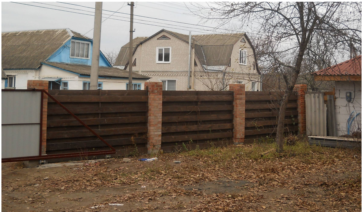
Фото 37. Загальний вигляд паркану з головного фасаду садиби. Фрагмент дворового простору садиби.
