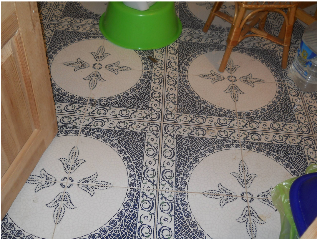
Фото 30. Вигляд підлоги з керамічної плитки санвузла мансардного поверху.
